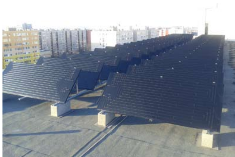
3. generációs napkollektor - a termodinamikusszólár rendszer 12.000 liter HMV állít elő egyidejűleg
