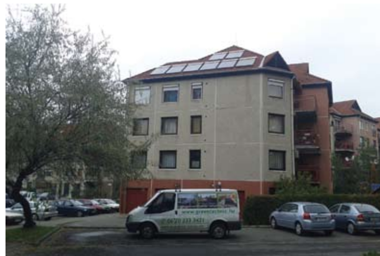
12 lakásos kaposztásmegyéri társasház - egy modern vákuumsöves kollektor, 1000 literes HMV tárolóval
