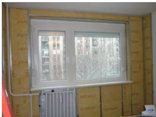
ISOVER Multimax 30 üvegyapot hőszigetelés a fémváz között
